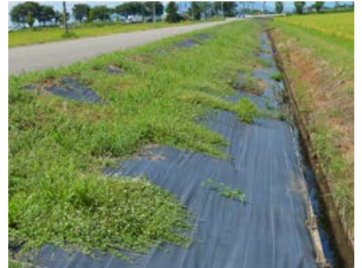
水路脇に設置した防草シート。資材は広域協定全体で購入するのでロットが大きくなり、安く仕入れられるのもメリット（新潟県・見附市広域協定）
